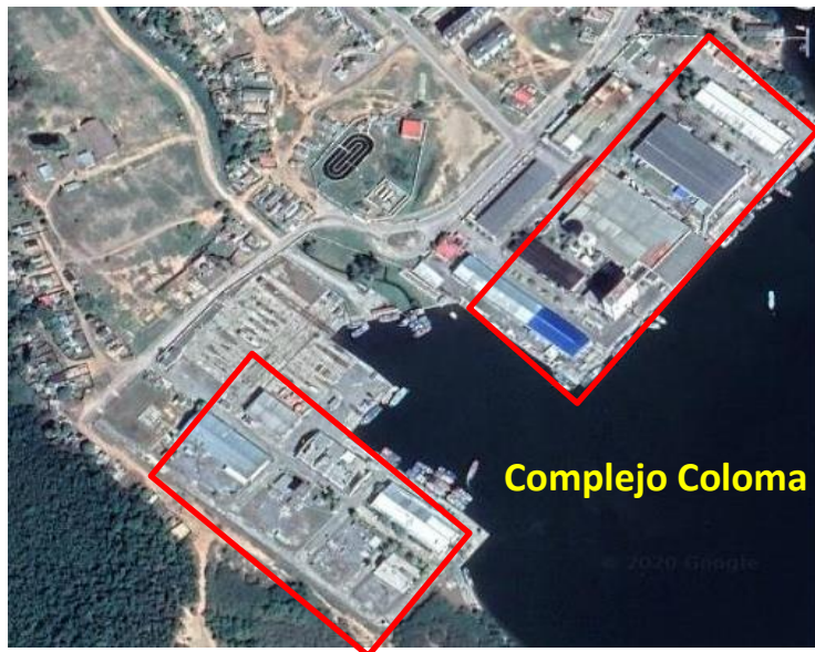
Figura 2.1 Vista satelital de la Empresa Pesquera Industrial de La Coloma, Complejo Coloma.
